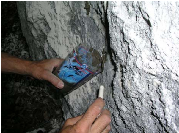
Bild 3: Verarbeitung des Biber Rapid Mörtels
